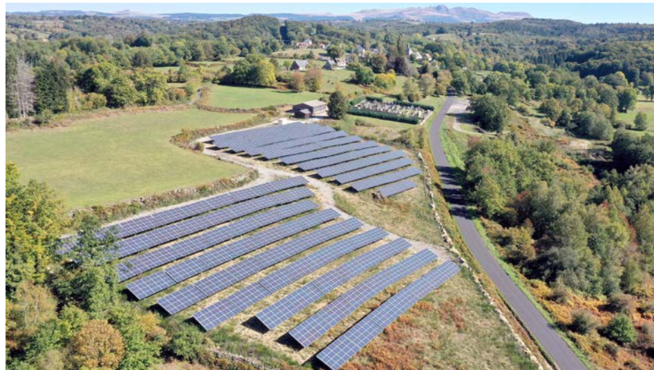
3 960 panneaux ont été installés pour une surface de 6 574 m 2 .
